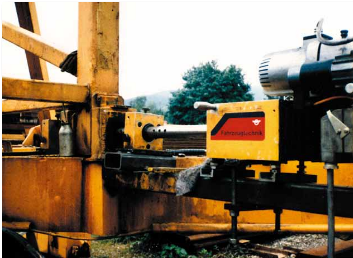
Verbolzung eines Gittermastkranes Turmstück aufgebohrt und Bolzen erneuert
