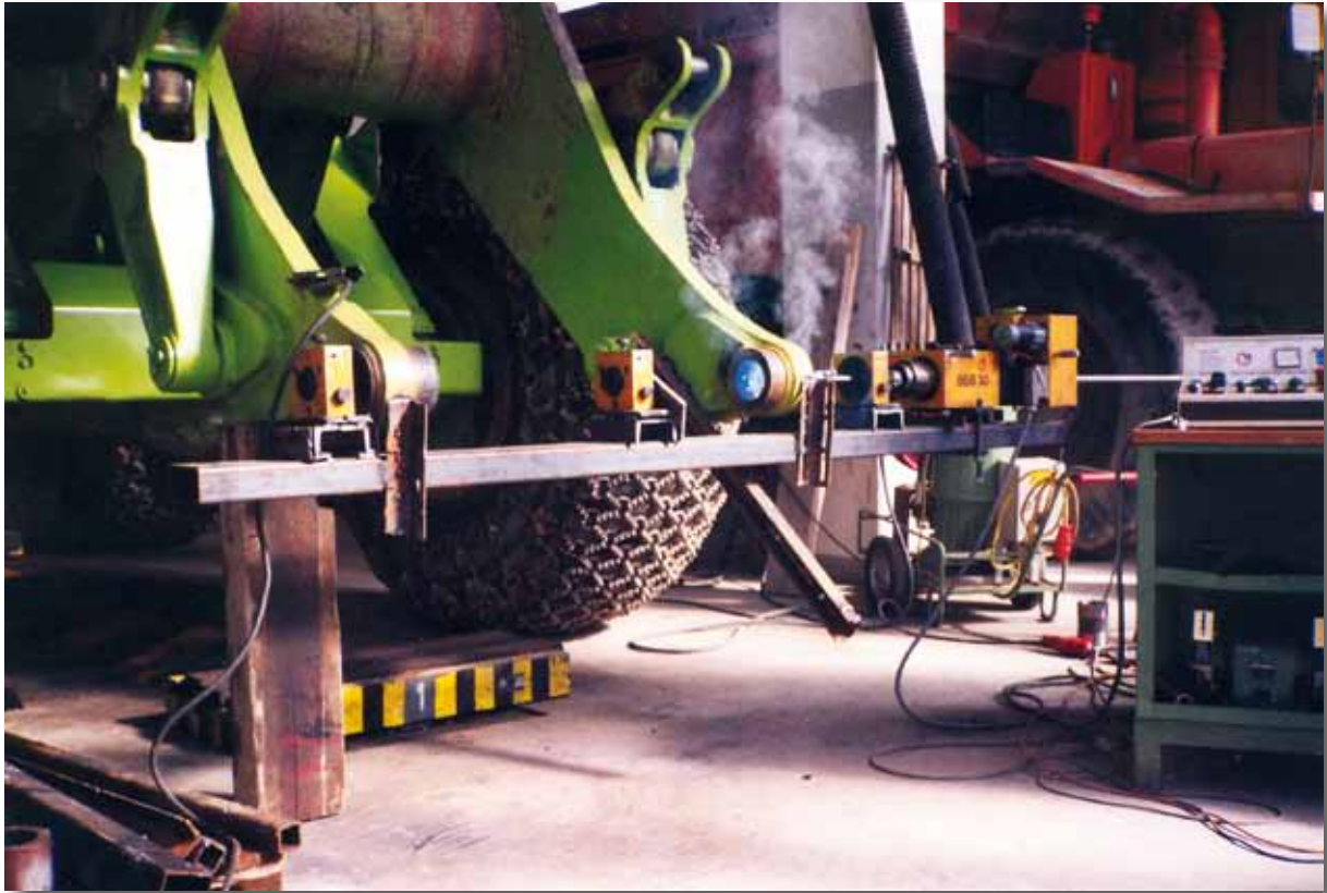
Hubschwinge Radlader Aufnahmebohrungen an Kippschaufel aufschweißen und bohren
