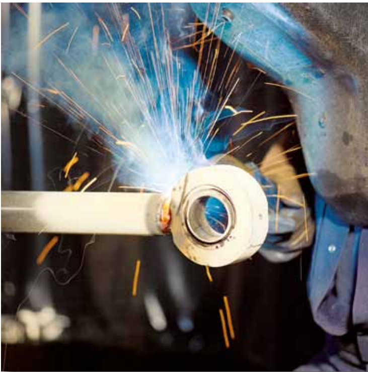
Anschweißen eines Bolzenauges
